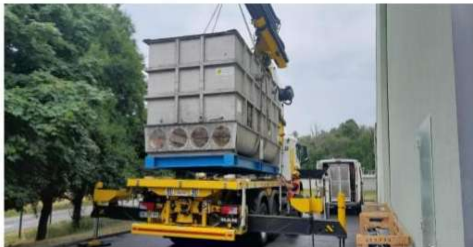
Evacuation Trémie à boues
