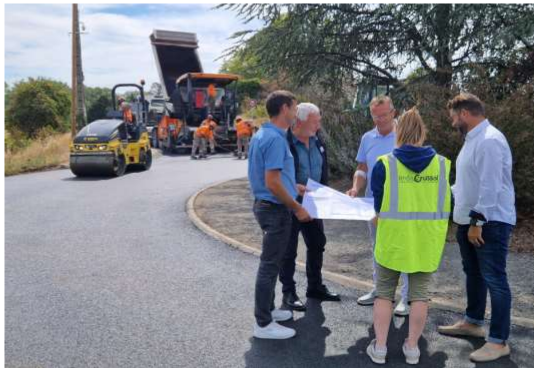
Route de Monneron à Saint-Péray
