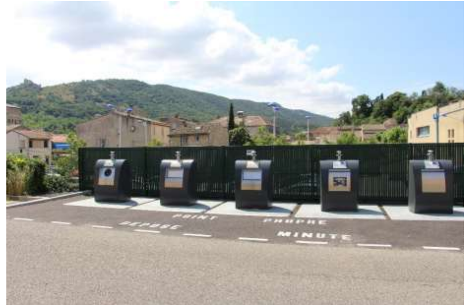
Colonnes enterrées à Saint-Péray
