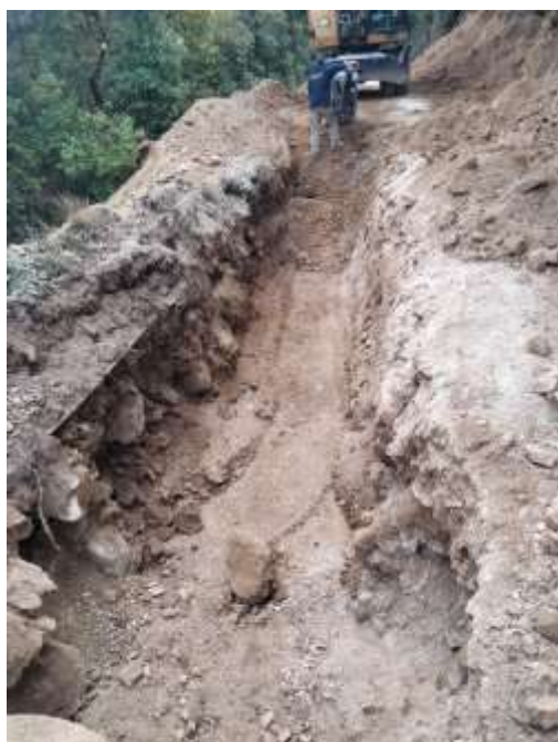
Travaux sur Saint-Georges-les-Bains
