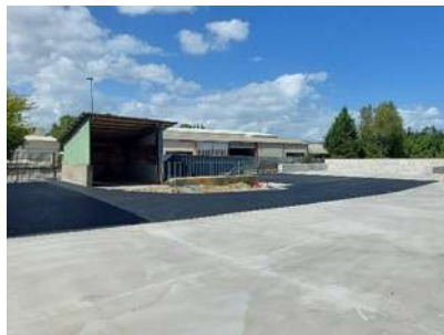
👉 Réhabilitation de la déchetterie de Toulaud
