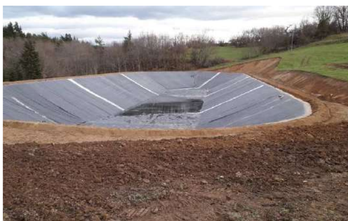
Création d'une retenue de substitution à Désaignes en janvier 2021 permettant de substituer 10 000 m 3
