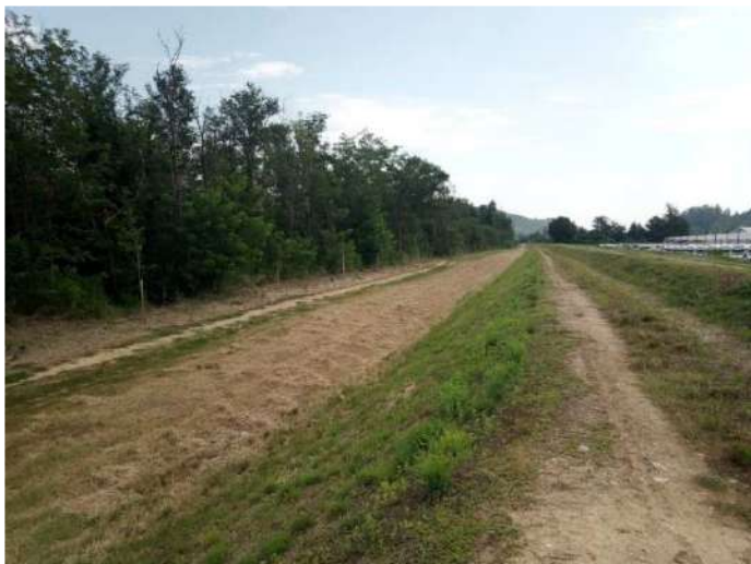
Digue en rive droite après entretien de juillet
