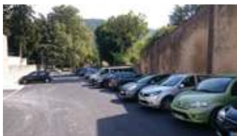
Fin des travaux place Richard
