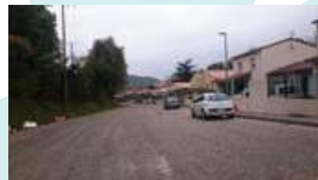
Réfection de la voirie et des réseaux chemin de Ploye
