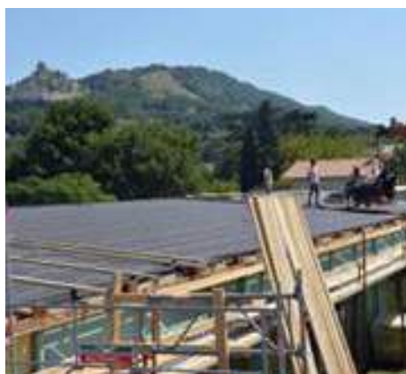
La toiture de l'école des Brémondrières a fait l'objet d'un important chantier cet été
